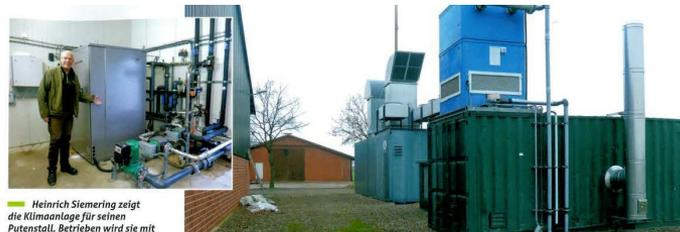
Heinrich Siemering zeigt die Klimaanlage für seinen Putenstall. Betrieben wird sie mit der Wärme aus dem Biogas-BHKW.
