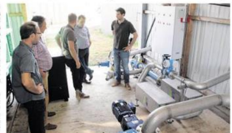
Tag des offenen Hofes in der Biogasanlage der Firma Agrar Energie Gesellschaft Techtentin mbH + Co KG. Präsentiert wird ein Ultraschallreaktor der Firma Weber Entec (rechts im Bild).
