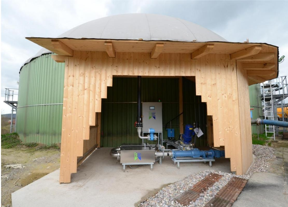
Abb. 5: Ultraschalldesintegrationsanlage von Weber Entec in Jühnde
