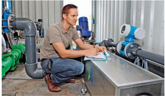
Anting Grams vom Ultraschall-Spezialisten Weber Entec beim Ablesen der Durchflussmengen durch einen der Ultraschallreaktoren in der Biogasanlage Jena.
