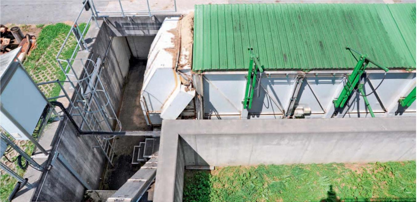
Der Substratmix aus Silage, Ziegenmist und Schrot wird alle 20 Minuten über einen Förderer in den Fermenter eingetragen.
